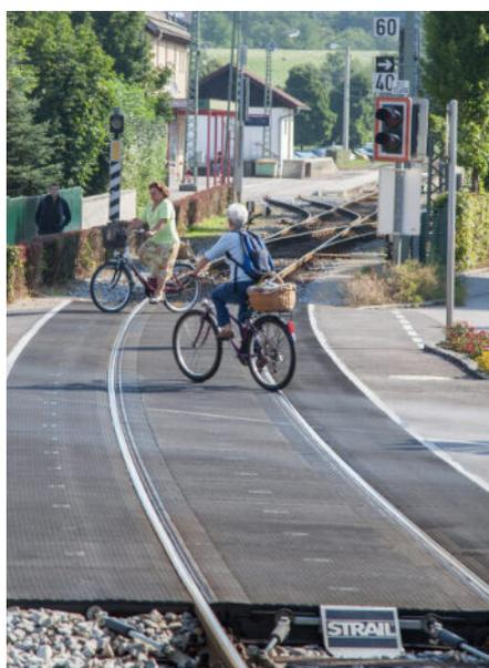
Das weltweit einzigartige System veloSTRAIL aus Tittmoning schließt die gefährliche Rille zwischen Gleis und Bahnübergang und macht das Überqueren barrierefrei.
